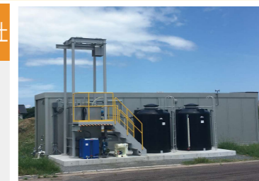
築上町液肥濃縮施設
