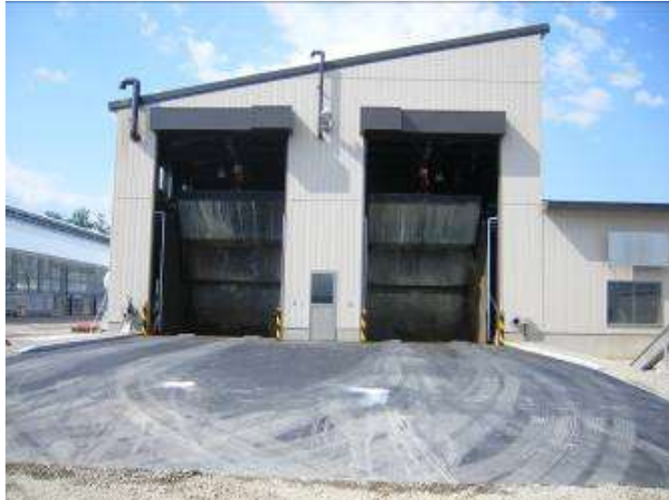
管理室・原料槽
