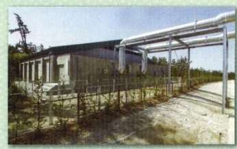
ロックワール脱臭槽 (容積900m) 全景
