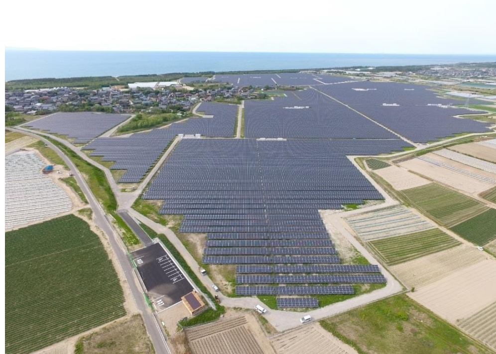
太陽光発電所（メガソーラー）新潟県四ツ郷屋発電所」 2018年7月稼働 用地面積78ha
