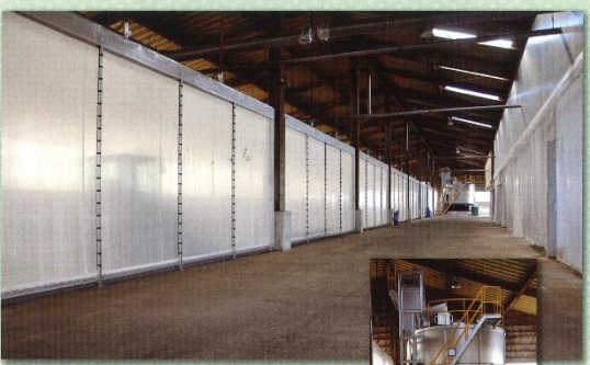
醱酵室内のカーテン・臭気吸引ダクト (工場内は常に陰圧となります)
